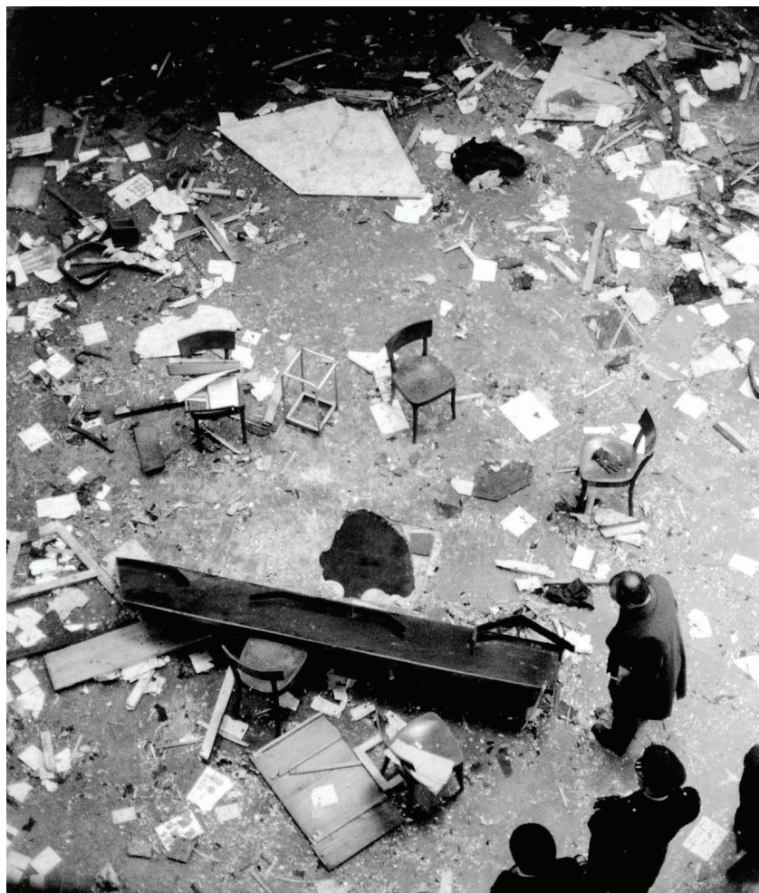
Milano, dicembre 1969: lo squarcio lasciato dalla bomba del 12 dicembre sul pavimento della Banca Nazionale dell'Agricoltura di Piazza Fontana.
