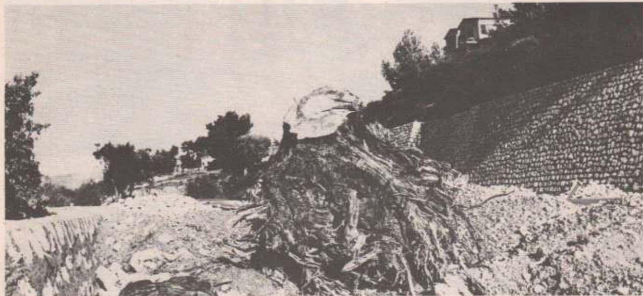
2) la nouvelle pénétrante : ce mur de plusieurs kilomètres de long, les Saint-Paulois l'ont baptisé « mur de la honte ».
