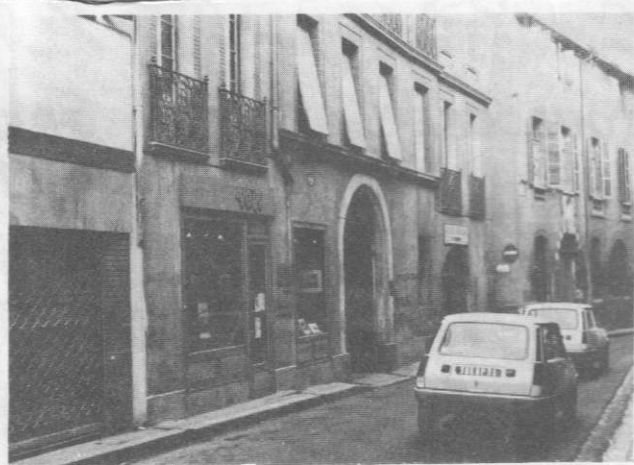
C.M.P "ROUTE NOUVELLE" - RUE PARGAMINIÈRES -
