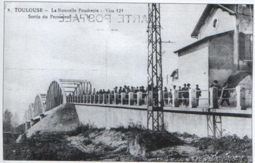
Dès 1917 fut livré aux véhicules et personnels de la Poudrerie un nouveau pont, légèrement en amont de celui du chemin de fer. Il avait été construit par l'entreprise Hennebique selon le principe d'un pont suspendu rigide à système *bowstring*. Le tablier de l'ouvrage était en béton armé.
