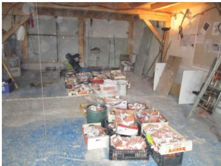
photo 18 - Le mur en briques des WC est abattu. Les gravats comme les précédents sont entassés et transportés à la décharge.
