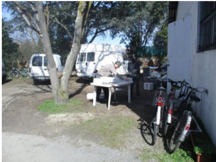
photo 10 - Mars - Brique de béton cellulaire taillé à la scie circulaire
