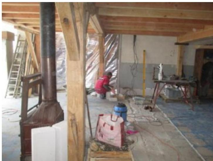
photo 12 - Montage d'un mur en Siporex à droite de la porte donnant sur le jardin
