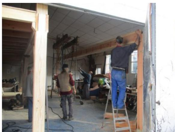
photo 1 - La poutre D (9m, 300 kg) est mise en place.
