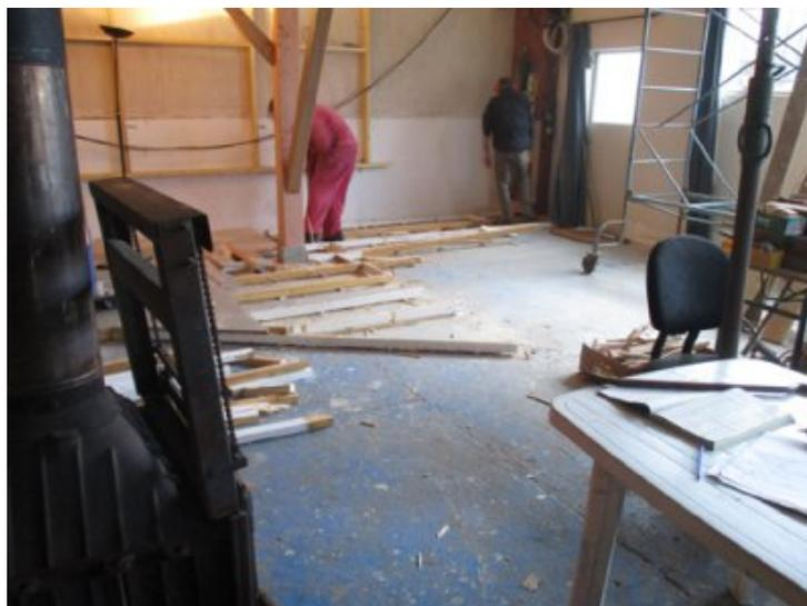
photo 6 - L'ancien plancher est démonté.
