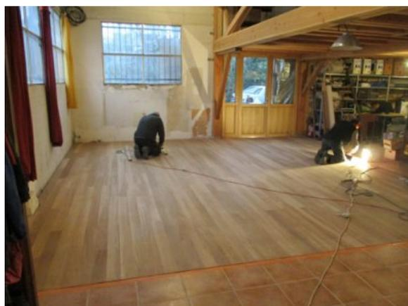
photo 20 - Ponçage des lattes du plancher.
