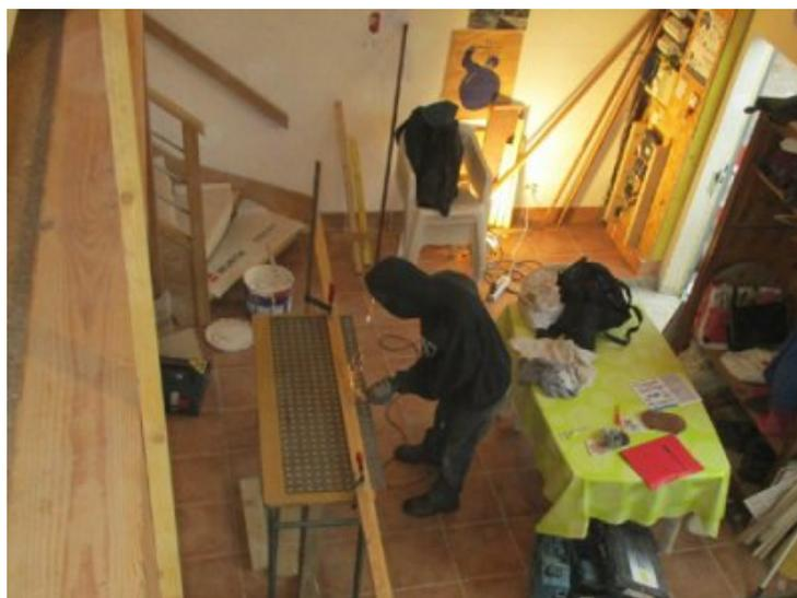
photo 11 - Découpe de la porte du coffrage de la box qui sera installée sous le compteur électrique.
