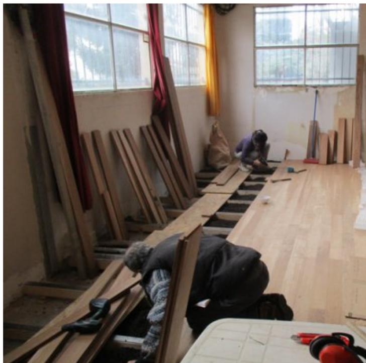
photo 19 - Entre les lambourdes pose de granulés de liège naturel pour l'isolation du plancher.
