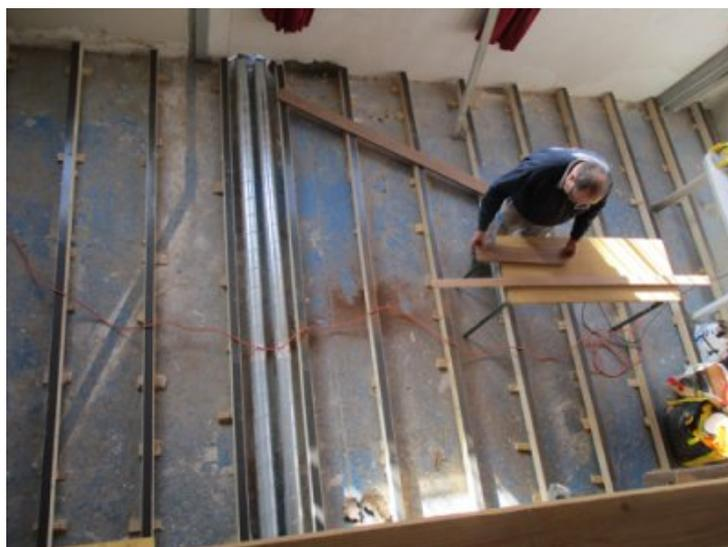
photo 17 - Plancher : Lambourdes installées ainsi que que les tuyaux pour l'arrivée d'air du poêle à bois.
