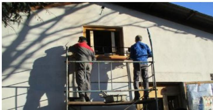
photo 3 et 4 - Travaux pour l'installation d'un garde-corps sur la fenêtre extérieure.
