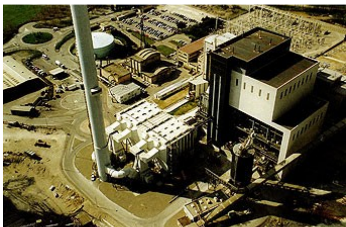
Centrale LFC 250 MWe de Gardanne.
