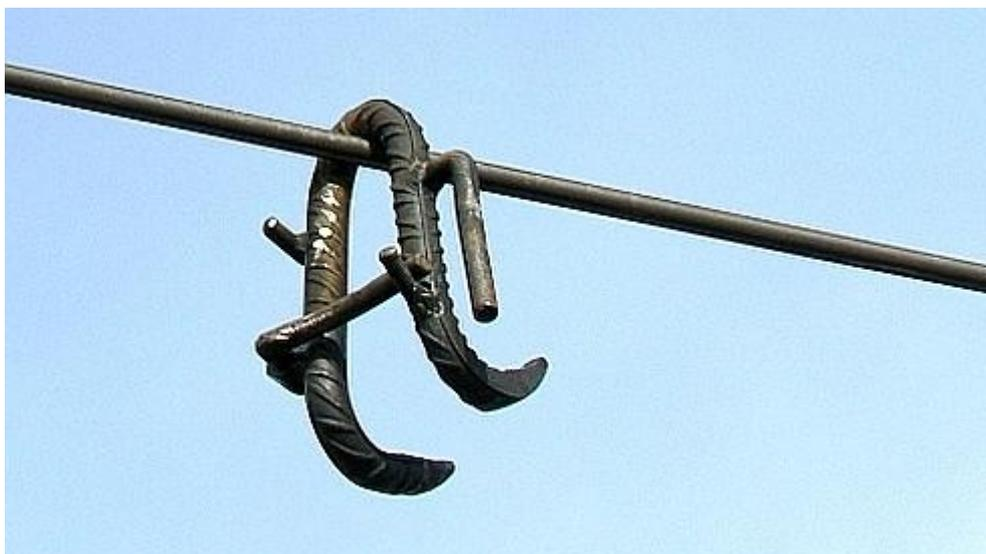
Voici un des systèmes de sabotage utilisé : un fer à béton ouvragé en forme de crochet est arrimé au câble de la caténaire, situé à sept mètres de hauteur le long de la voie. Photo le Figaro Magazine
