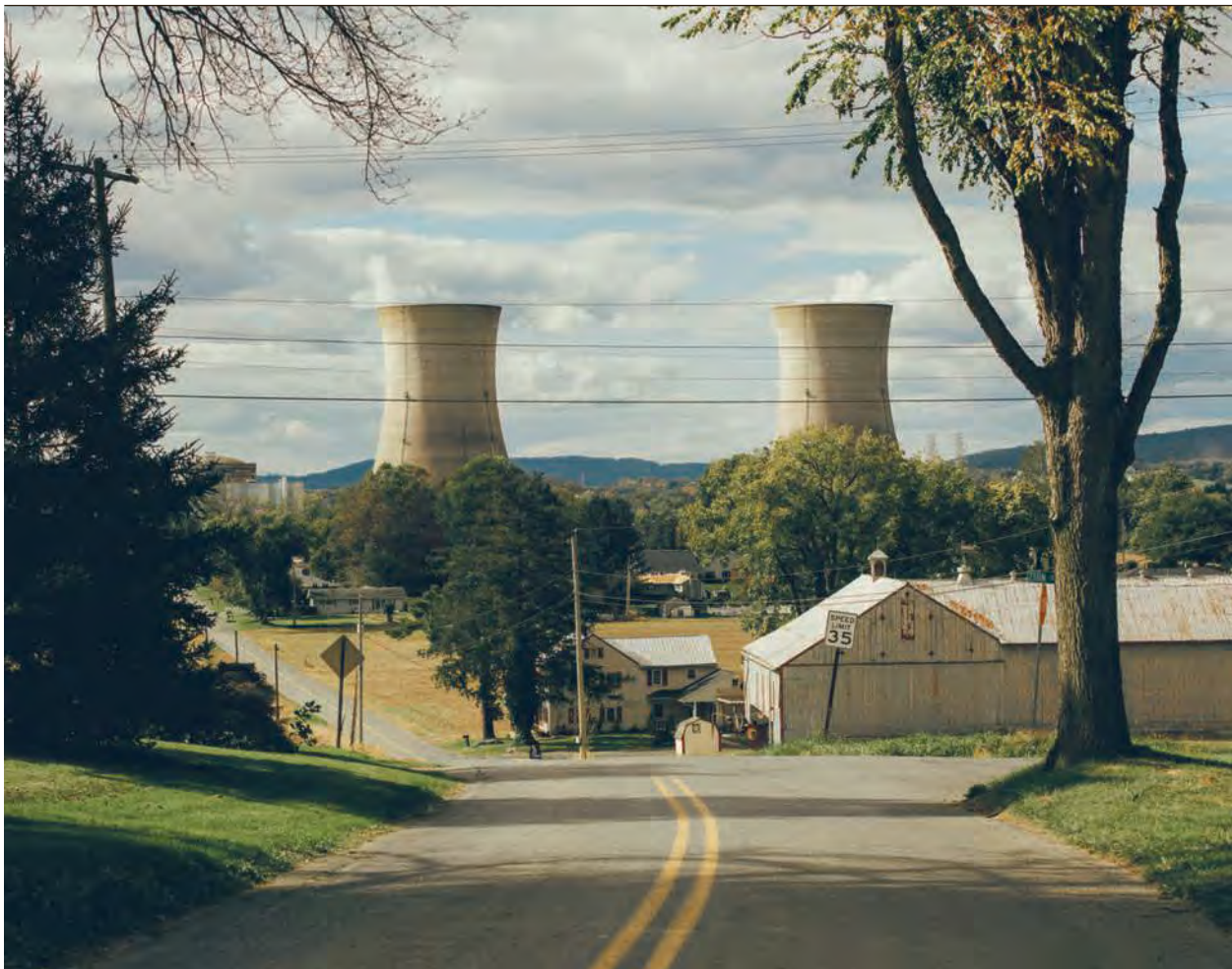
GEORGE ETHEREDGE. – Tours de refroidissement de la centrale nucléaire désaffectée de Three Mile Island, près de Middletown, en Pennsylvanie, 2024
