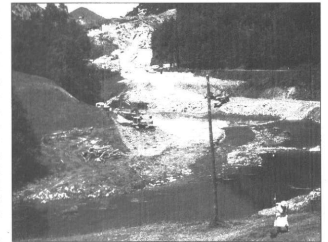
Ci-dessus, de haut en bas : une des multiples actions de soutien (ici en 1993) devant le Ministère de l'Environnement. Le début des travaux en 1993.
