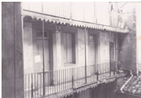
1990 - Rue Compans - Local au premier étage d'une cour intérieure.
